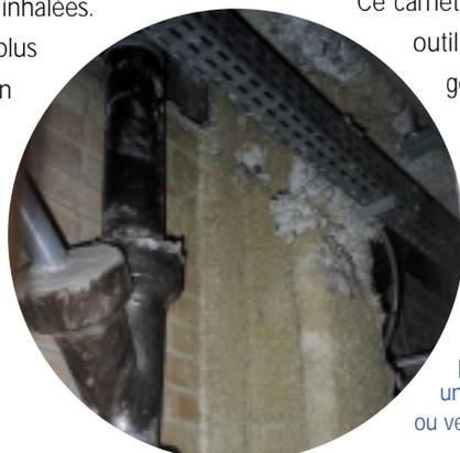
Flocage d'amiante : matériau d'isolation par projection présentant un aspect fibreux, duveteux ou velouté.
