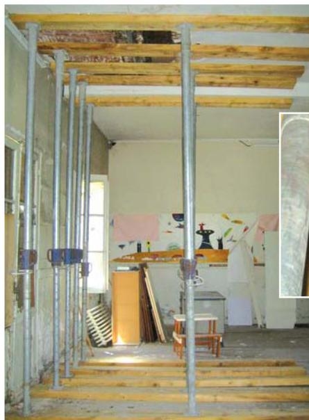
L'expert recommande un étaieement du plancher jusqu'à réalisation des travaux qu'il a préconisés.
